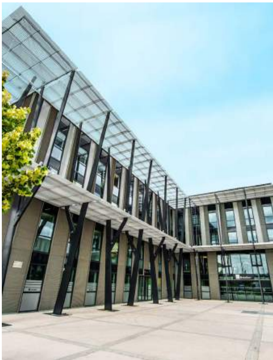
Rue de Beauvais - Margny-lès-Compiègne
