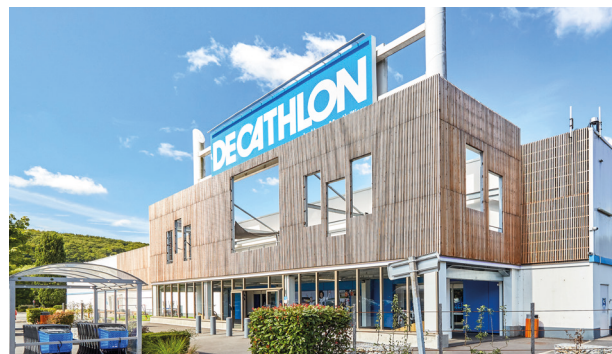
Centre commercial La Lézarde - Montivilliers (Le Havre)
