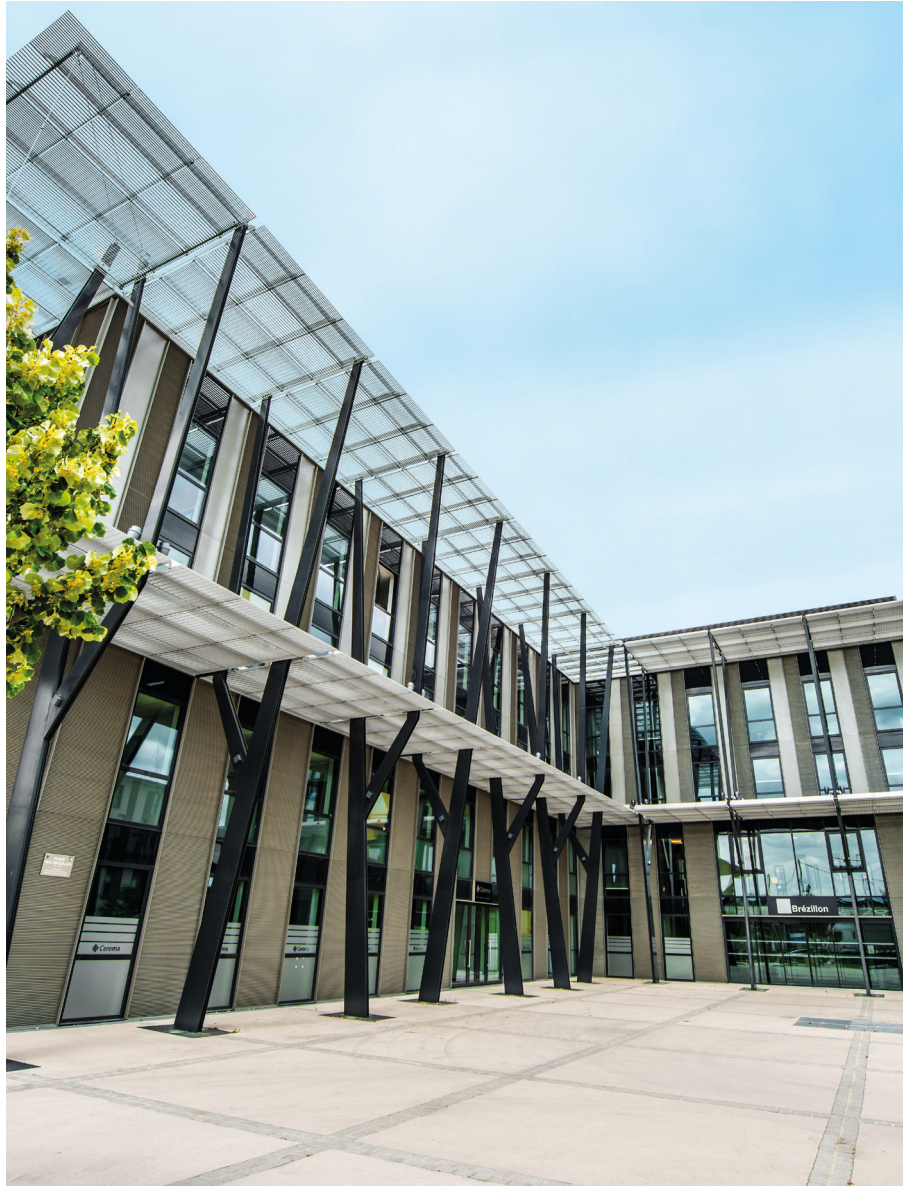
Rue de Beauvais - Margny-lès-Compiègne
