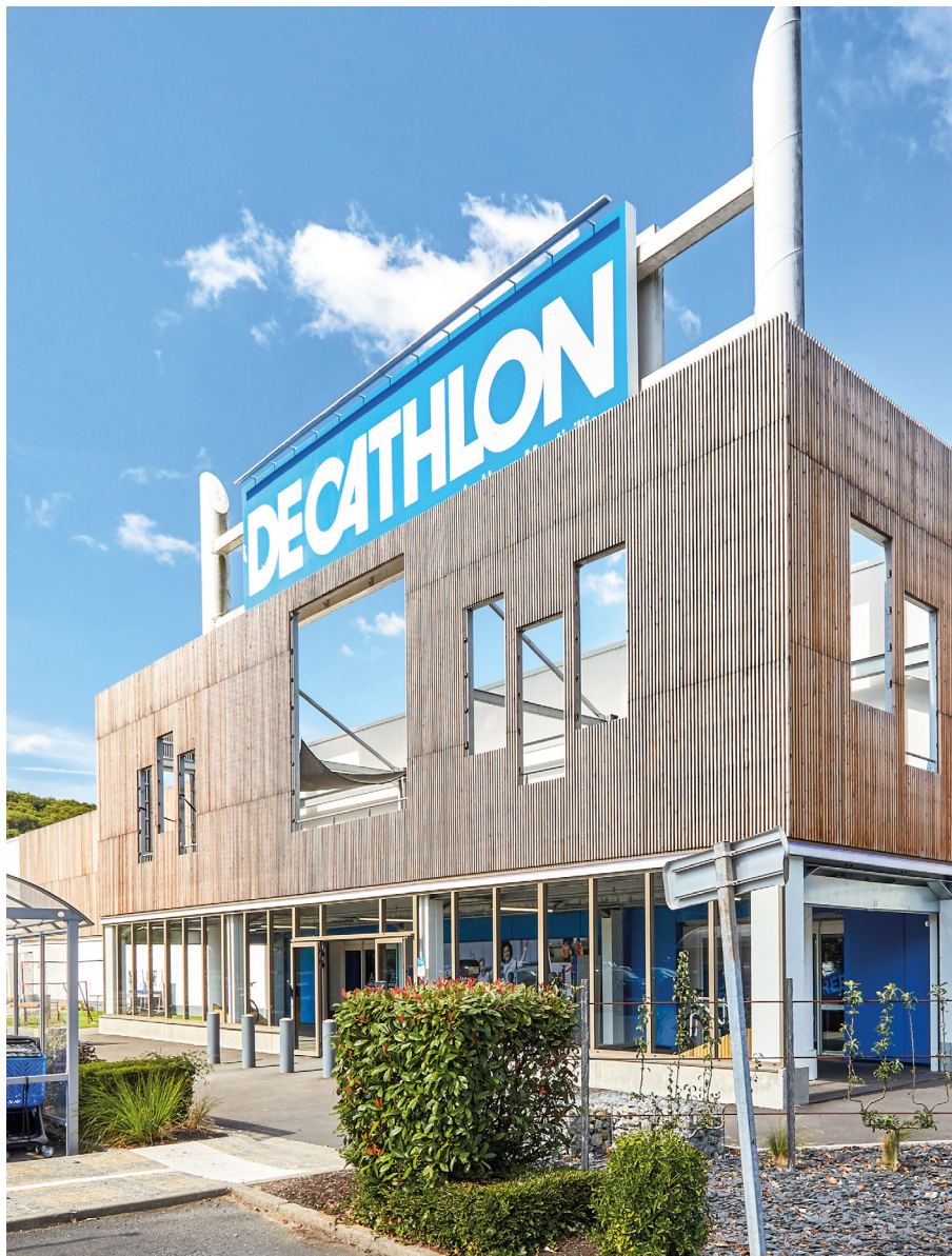
Centre commercial La Lézarde - Montivilliers (Le Havre)
